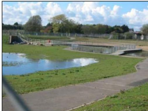
Depósitos de Infiltración
